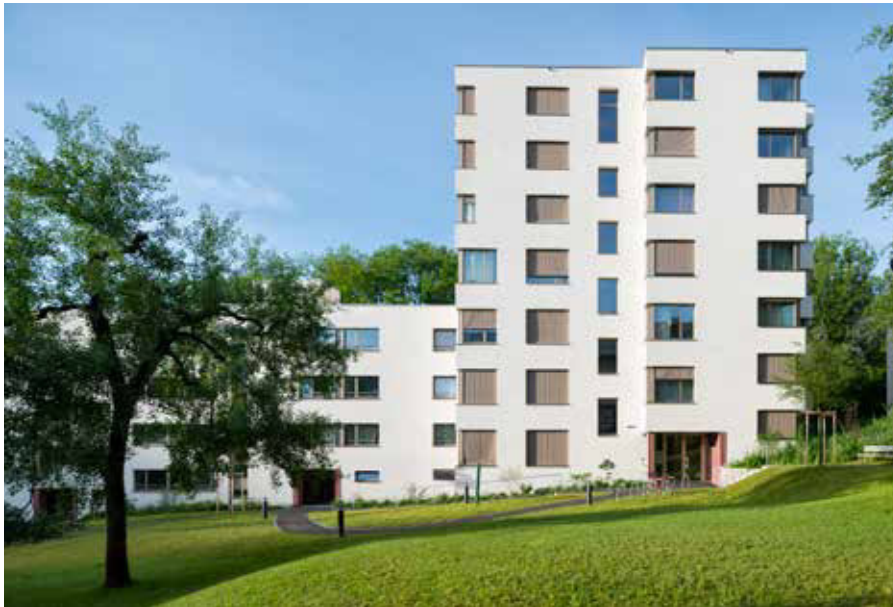
Oben: Äusserlich kommen Alt- und Neubau aus einem Guss. Rechts: Rücksprünge in der Fassade ermöglichen attraktive Eckfenster im Anbau.
