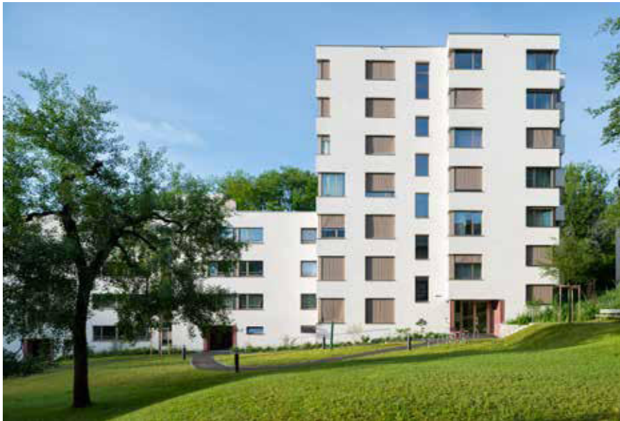
Oben: Äusserlich kommen Alt- und Neubau aus einem Guss. Rechts: Rücksprünge in der Fassade ermöglichen attraktive Eckfenster im Anbau.
